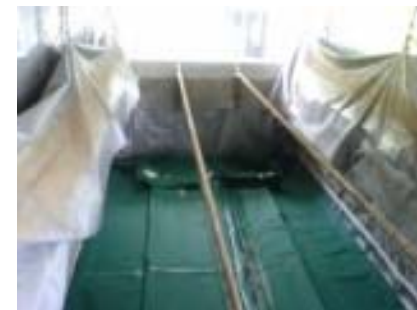
保護シートをかけ、 タンクをセットする
