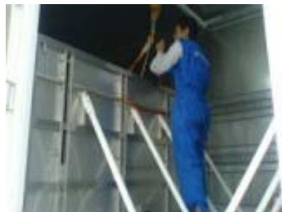
バルクヘッドをブレスで固定する
